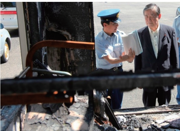
火災調査実習の模擬家屋の説明を受ける奥野総務副大臣（右側）
